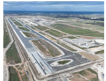
Xây dựng đường băng WSI
