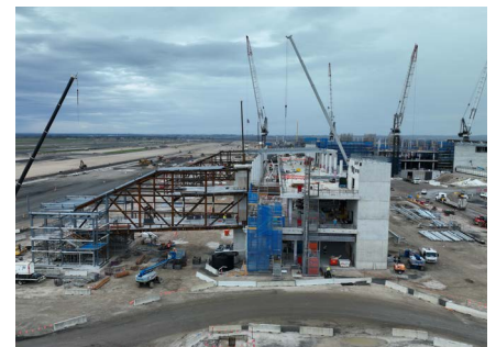
Xây dựng ga sân bay WSI
