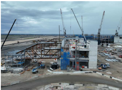
تشديد مبنى مطار WSI
